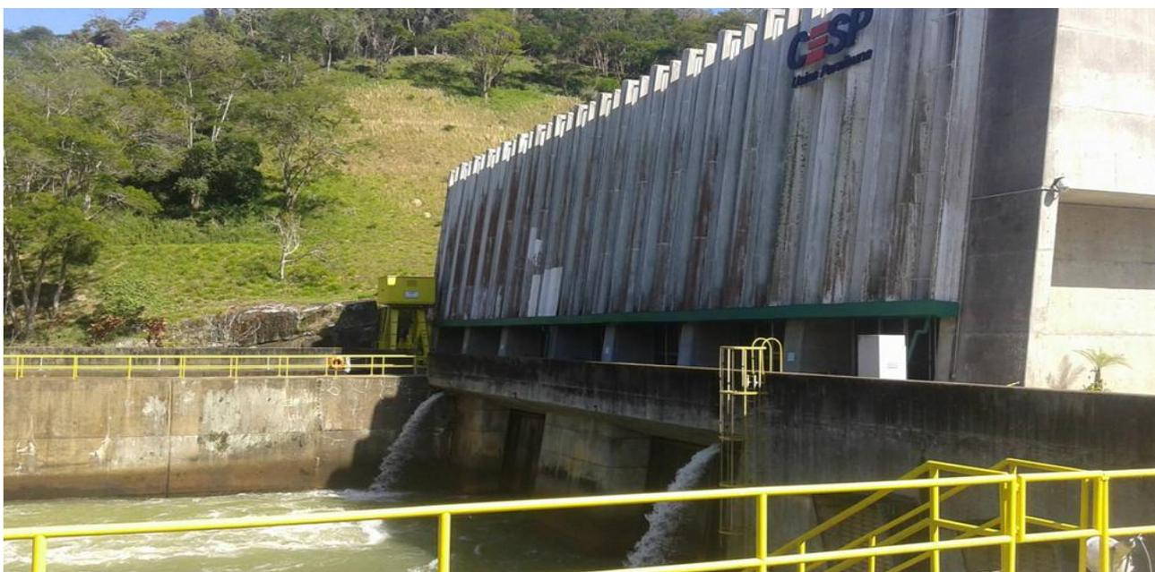
Foto 29: A represa da CESP Paraibuna: A represa contribuiu para o controle das cheias e da vazão da água para consumo e produção de energia elétrica para a região metropolitana do rio Paraíba do Sul.
